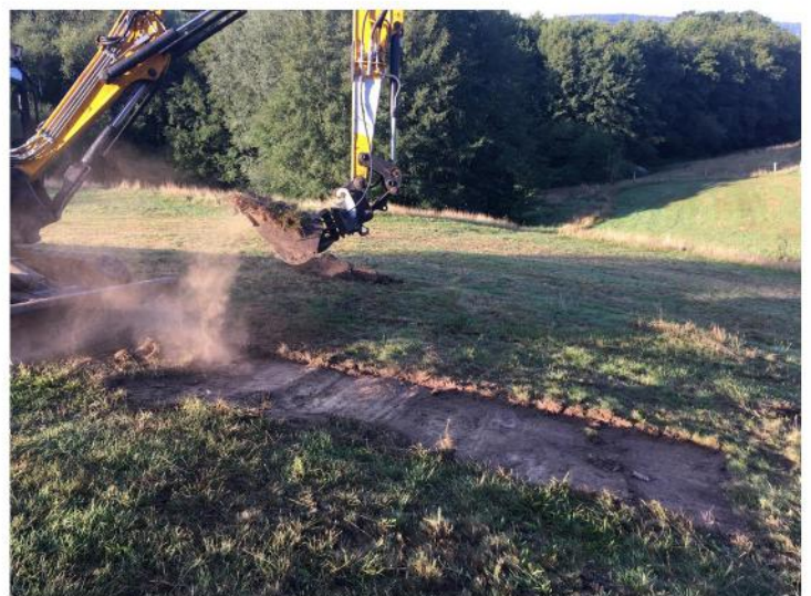
Het afgraven van de bovengrond
